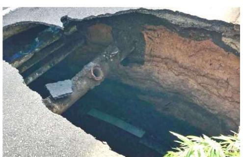
大深度地下シールド工法による陥没
